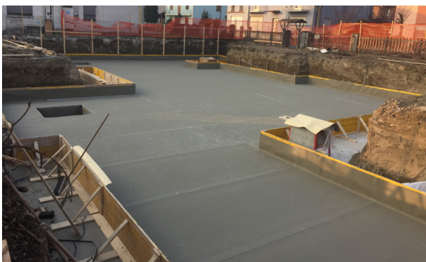
Application classique de SikaProof® A+ en radier.
