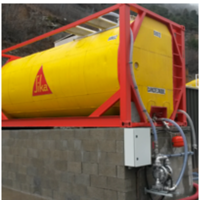
Cuve pour adjuvant (cuve thermostatée pour maintien en température du Sigunit, pour une meilleure performance lors de la projection)
