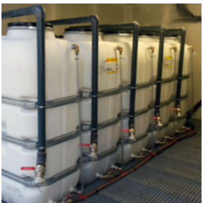
Cuves à simple ou double parois de 800 à 5 000 l pour stockage des adjuvants sur chantier
